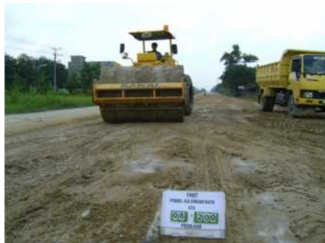
Gambar 3. Proses penimbunan dan pengerasan.
