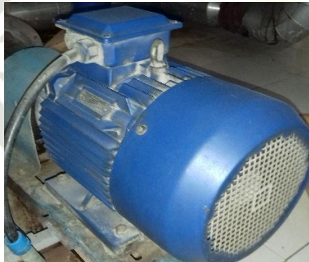
Gambar 2.9 Motor 3 phasa [2].
