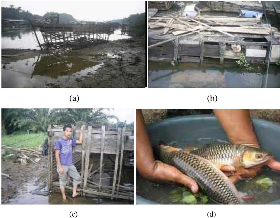
Gambar 1.2. (a,b,c) Keadaan Keramba yang rusak dan (d) Ikan Jelawat
