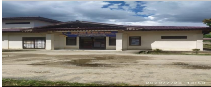
Gambar 4.15 Bangunan 2 Penyimpanan Produk (Sumber: Observasi Lantai Produksi UPTD Pengolahan Dinas Perikanan, 2020)
