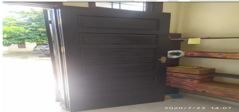
Gambar 4.19 Pintu Ruangan (Sumber: Observasi Lantai Produksi UPTD Pengolahan Dinas Perikanan , 2020)
