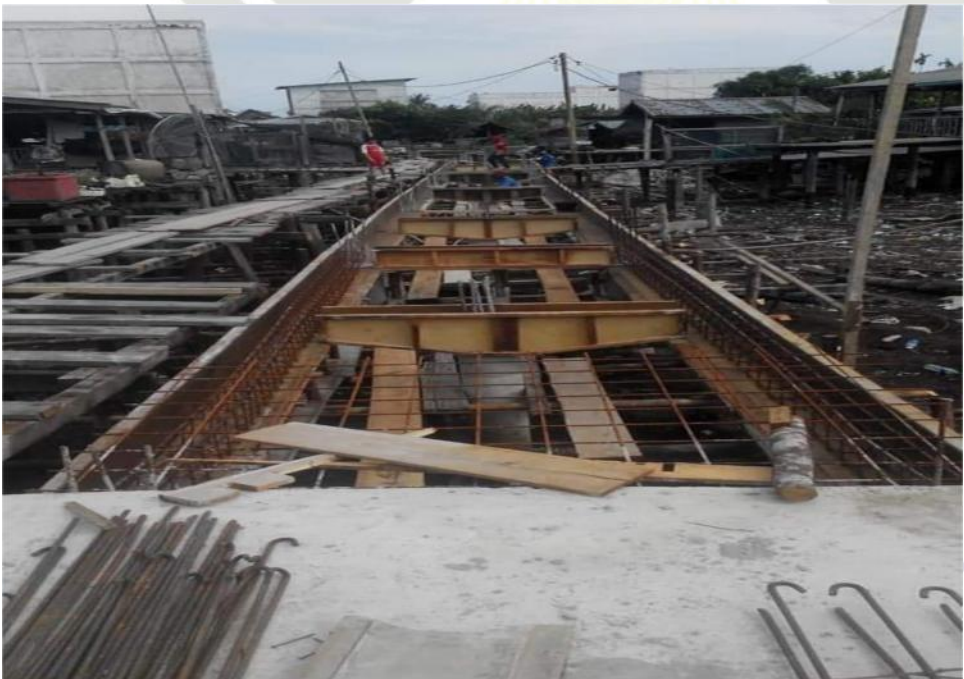
Pembangunann Jembatan Jalan Nelayan Tahun 2019
