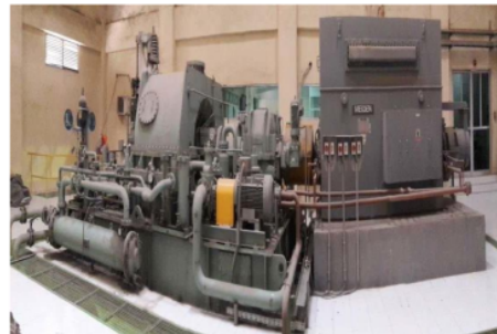
Gambar 1. Generator Sinkron pada WHRPG
