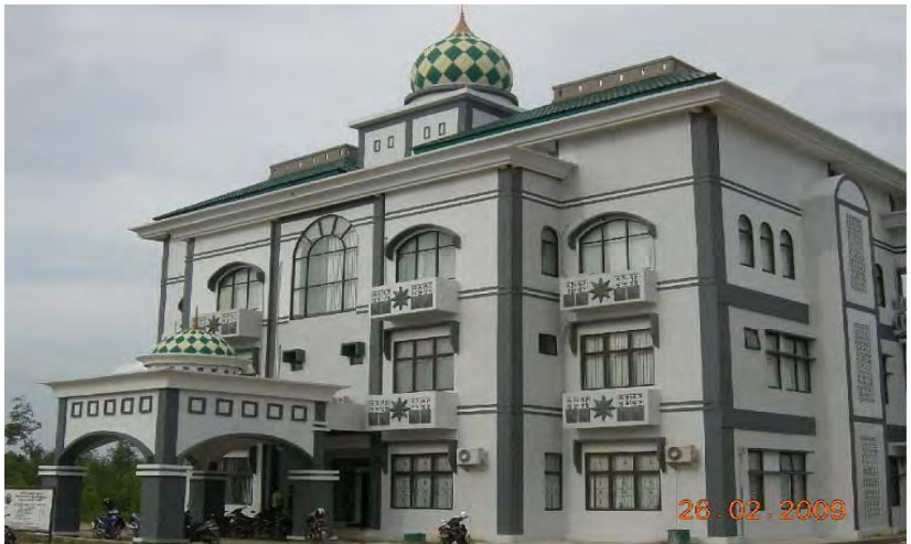
Gambar 80. Gedung Laboratorium Fakultas Sains dan Teknologi UIN Suska Riau
