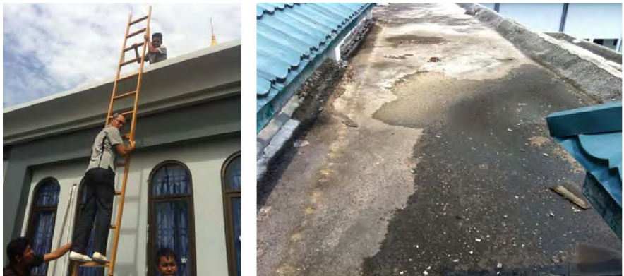
Gambar 91. Survei lokasi instalasi modul surya di atap Gedung Laboratorium Fakultas Sains dan Teknologi
