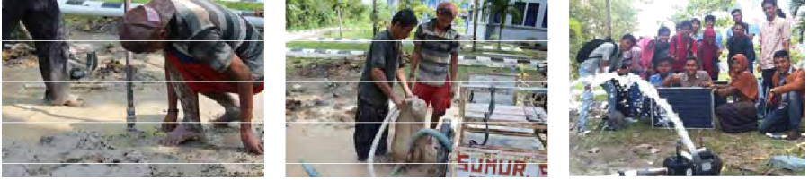
Gambar 90. Persiapan sumur bor
