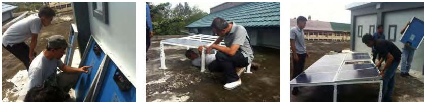
Gambar 93. Pemasangan modul surya
