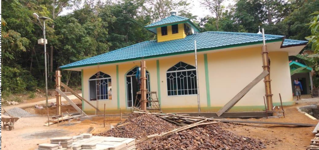
Pembangunan tempat whudu masjid Al- Mukmin sekaligus pembutan tempat parkir motor di Desa Penarah Kecamatan Belat Kabupaten Karimun.
