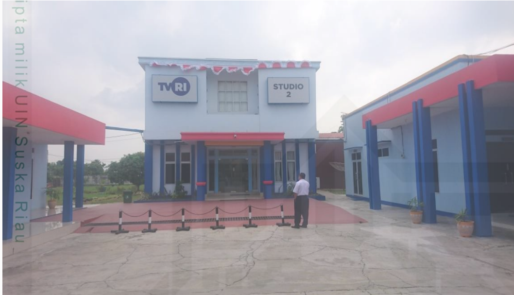
Gambar 1 : Tampak luar Studio 2 LPP TVRI Stasiun Riau
