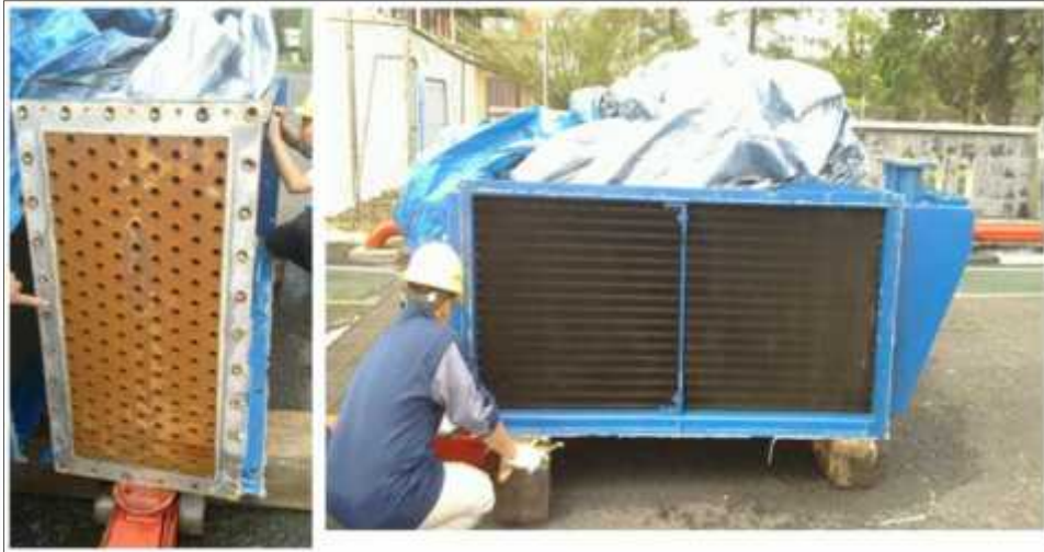
Gambar 2.3 Generator Cooler di Pembangkit Listrik Tenaga Panas Bumi (Ria Mahmudah, 2013).
