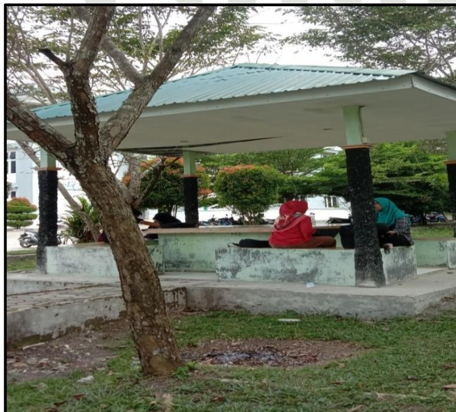
Gambar 1.2 Kondisi Bangunan Sumber : Dokumentasi Pribadi
