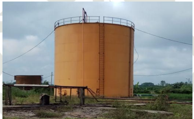
Tanki penyimpanan CPO
