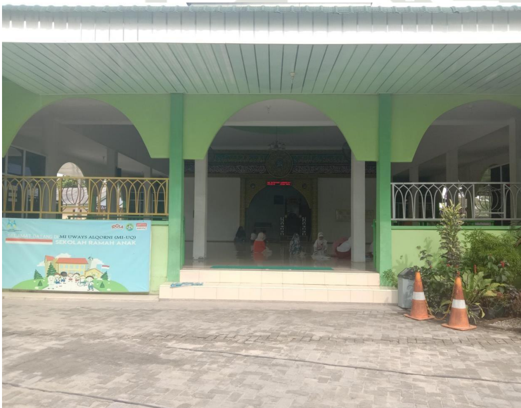
Mesjid yang berada di lingkungan MI Uways AlQorni
