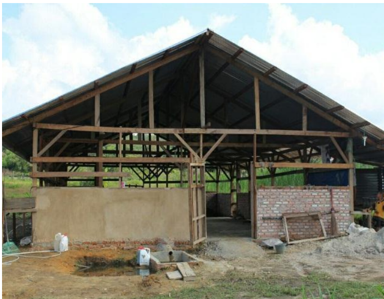
Gambar 8. Konstruksi kandang pada Kelompok Tenak KEM Batu Bersurat
