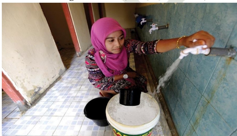
Gambar 4.2 Pembangunan MCK (Mandi Cuci Kakus)
