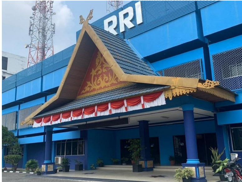
Gedung RRI Pekanbaru Jl. Jenderal Sudirman No. 440 Tanah Datar, Kecamatan Pekanbaru Kota
