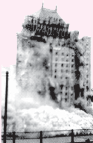
Gambar 2.3 Ledakan dengan TNT untuk meruntuhkan gedung bertingkat. Sumber: General Chemistry, Principles & Structure, James E. Brady, 1990
