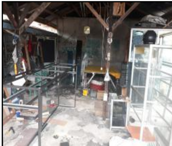
Gambar 1.5 Kondisi Area Kerja Sumber: Survei Lapangan, 2018
