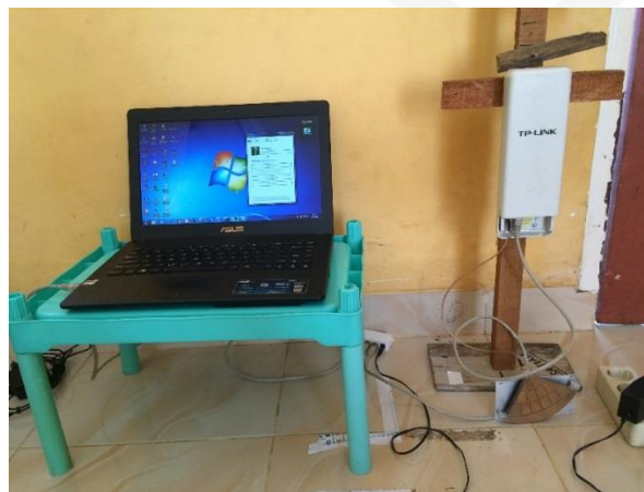
Gambar 3.22 Perangkat yang Bertindak sebagai Access Point atau Transmitter
