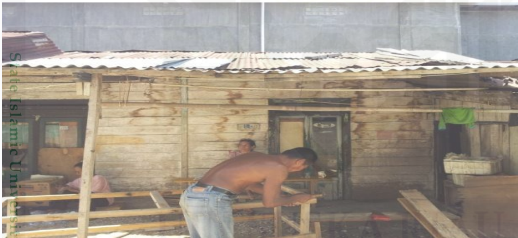
Gambar 1.1 Beberapa Gambar Rumah Tidak Layak Huni di Kecamatan Bukit Raya
