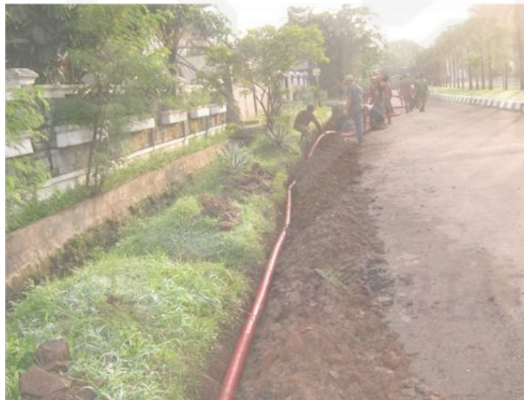
Gambar 2.4 Saluran kabel bawah tanah [13]
