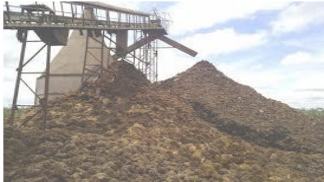
Gambar 2.3 Pembangkit Tenaga Biomassa
