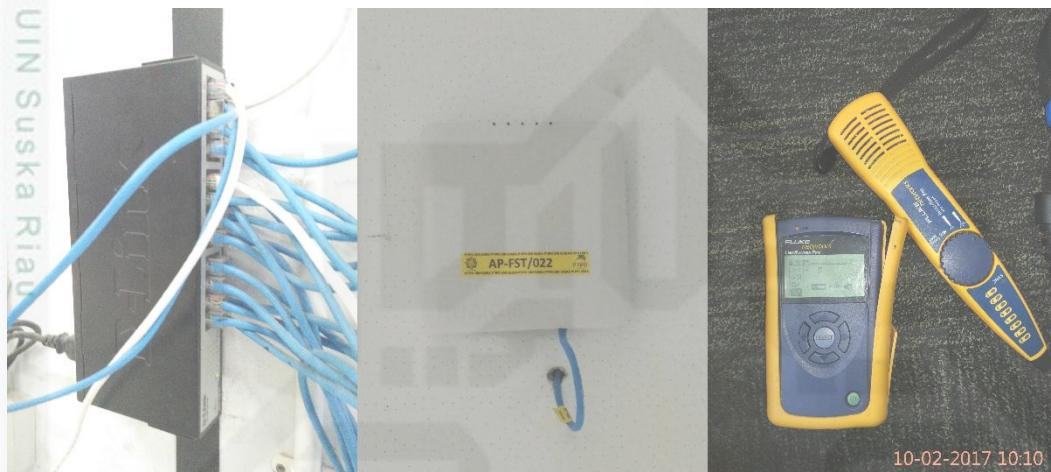
**Gambar 4.4 Switch (kiri), Access Point (tengah) dan Cable Tester (kanan)**
